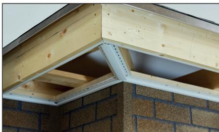
**3.3.** Для углового соединения панелей используется Н-профиль.
