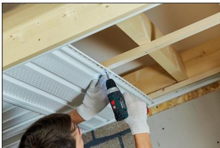
**1.4.** В направляющие профили вставляются панели и фиксируются при помощи саморезов к обрешетке.
