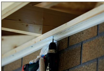
**1.3.** К обрешетке фиксируются направляющие профили (J-профиль) саморезами с шагом 300 мм. В месте соединения профилей подрезать часть профиля на 3-5 см и завести один профиль в другой для лучшего сопряжения.
