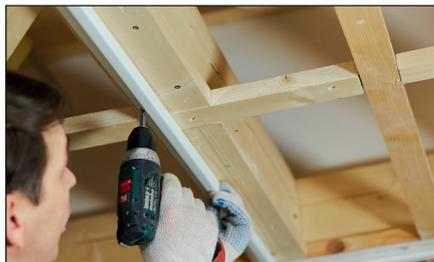
**3.6.** Второй вариант прямого соединения – при помощи J-профиля. Его устанавливаем от угла перпендикулярно одному из карнизов. Фиксируем саморезами к обрешетке и стыкуем друг с другом.
